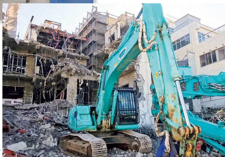
11月30日 東棟解体
